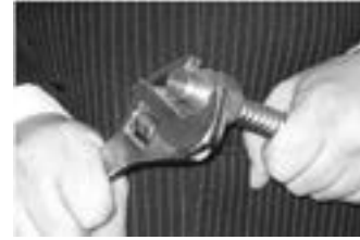
Рис 3 Затягиваем накидную гайку
