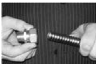
Рис 2 Вставляем в трубу фитинг до упора
