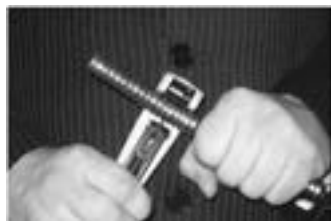
Рис 1 Аккуратно разрезаем трубу
